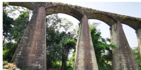
图 1 毛家河渡槽工程现状
