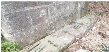
图 2 毛家河渡槽条石砌体基础钻芯取样
