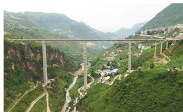
图7 桥梁贯通实景
