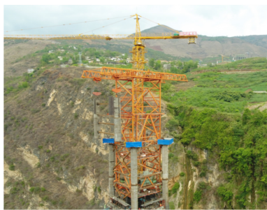
图 6 自爬式多功能提升系统安装实景
