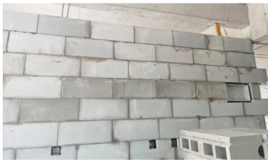
图 3 砌块组砌及开洞
