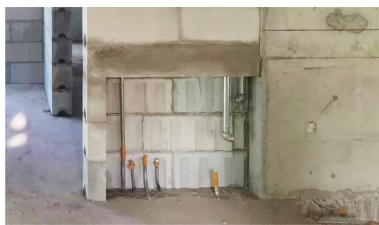
图 5 分集水器处墙体留洞
