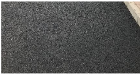
图6 广履路 OGFC-13 罩面施工效果
