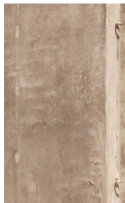
图 1 墙板侧面的吊环螺栓示意
