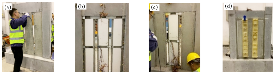
(a) 单块混凝土板安装; (b) 内部泡沫板安装; (c) 对侧混凝土板安装; (d) 模板完成封堵
