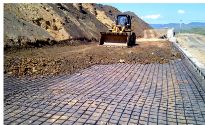
图 7 土工格栅铺设与回填
