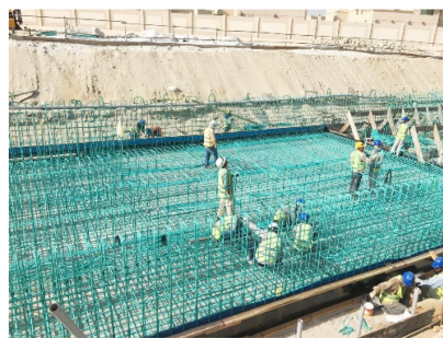
图 11 环氧树脂涂层钢筋应用
