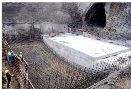
图 10 隧道仰拱施工
