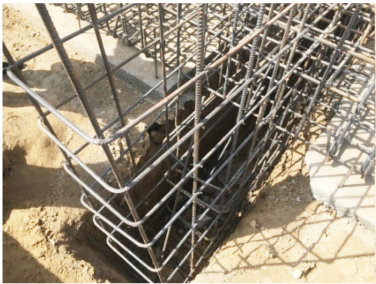
图 3 截渗环钢筋绑孔图
