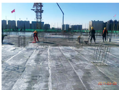
图 6 浇筑中塑料薄膜保水
