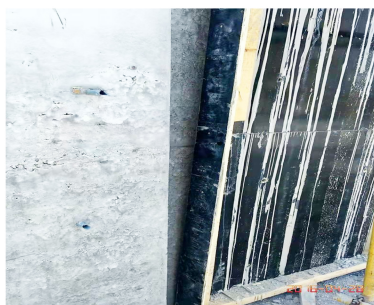
图2 振捣不到位骨料下沉
