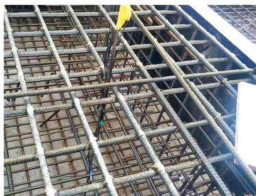
图 5 预埋电子测温线
