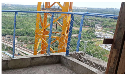
图 2 正式栏杆替代临边防护
