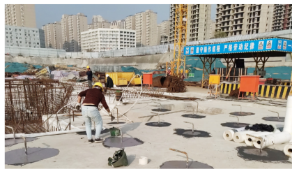
图 1 某项目加工区地面硬化与垫层/车库顶板的永临结合
