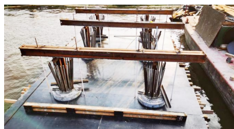
图 4 码头工程的桩头支撑
