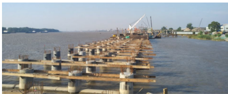
图 8 高桩码头工程的桩基工程完成现场照片
