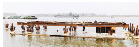
图 5 高桩码头的反吊施工工艺
