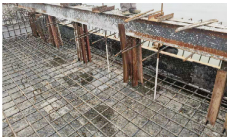
图 7 顶层反吊装置的预埋
