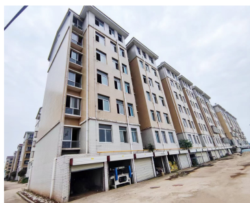
图 7 居民楼加固工程概况
