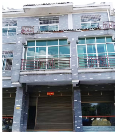
图 3 居民建筑群加固工程概况
