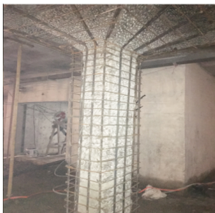
图 8 框架柱增大截面加固
