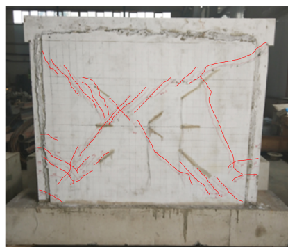
图 6 G-W-2 墙体破坏过程
