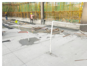
图 8 现场实施情况
