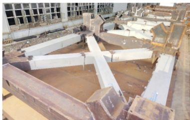
图 7 桁架预拼装效果
