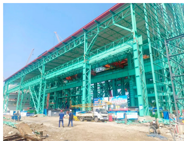
图 5 厂房现场图片
