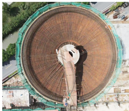
图5 下锥壳水柜钢筋施工
