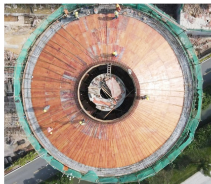
图6 上锥壳水柜模板施工
