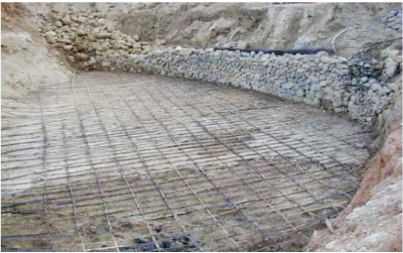
图 2 加筋现场处理
