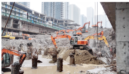
图 11 土方开挖实景
