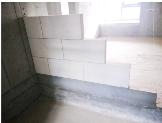
图 4 临时间断砌成斜槎
