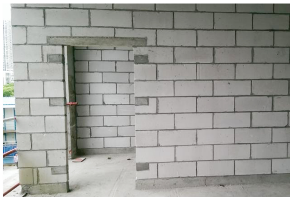
图 3 门窗洞口上方过梁成型
