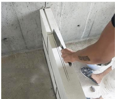
图 2 精确砌块切槽
