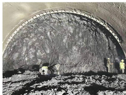
图 5 管棚定位钢架及施工效果
