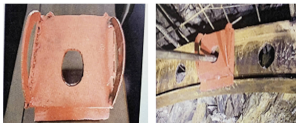
图 6 隧道超前导管施工定位装置示意
