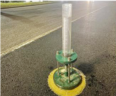
图 3 现场渗水检测
