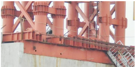
图 1 扣锚梁实图
