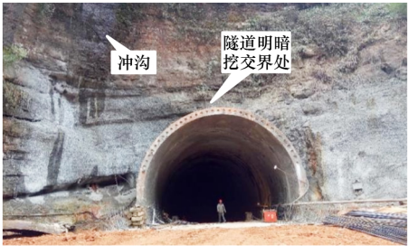
图 11 施工现场照片（旱季施工）
