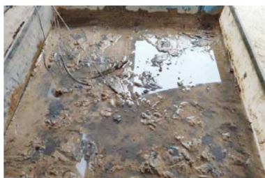
图 10 桩施工完成后的土表面
