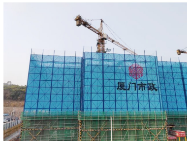
图 1 升降脚手架安装完成实景
