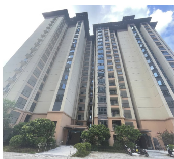
图 13 建成后的大都熙园 3#楼实景
