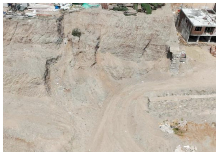
图 1 场地东南侧边坡现状
