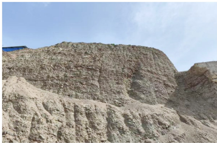
图 2 边坡节理构造调查现场
