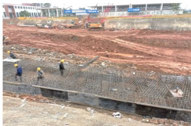
图 7 放坡喷锚 + 梅花形双排桩现场照片
