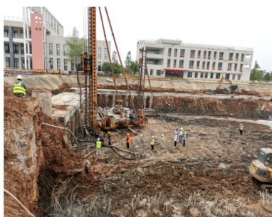
图 5 基坑被动区土体石灰桩加固现场照片
