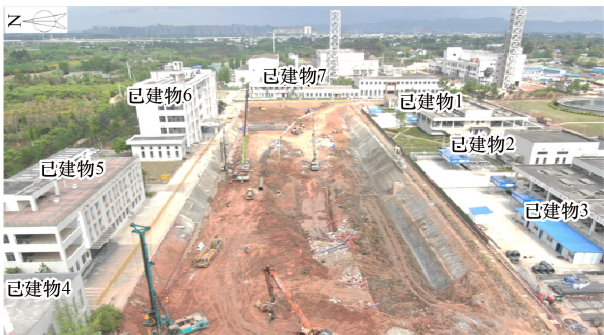
图 2 拟建某沉淀池基坑周边环境鸟瞰图
