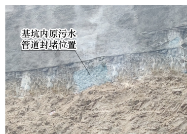
图 7 土方开挖后基坑侧壁
